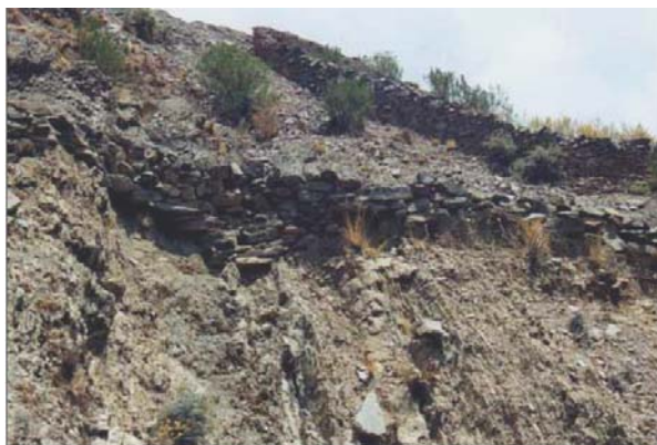
Figura 15. Detalle del muro de contención en el camino, sitio Huaylla Tambo Inca.
